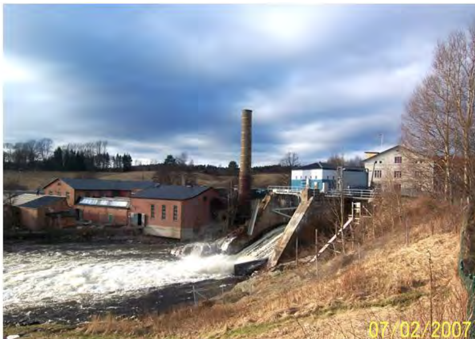
Hedefors kraftverk ligger norr om Lerum.
