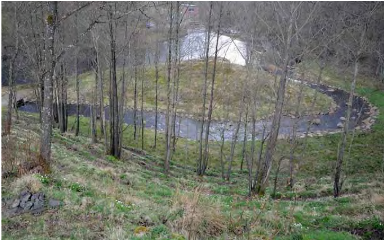
Omlöpet vid Bosgårdens kraftstation, en nybyggd vandringsväg i Storån som rinner genom Härryda och Marks kommuner. Foto: Monica Havström
